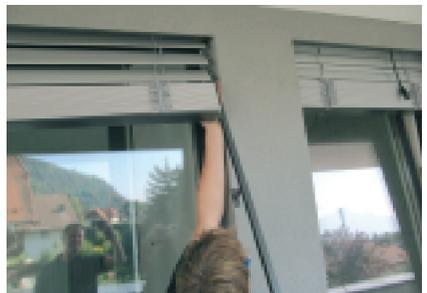
7. Die Führungsschiene vorsichtig in die Führungszapfen der Raffstorelamellen einführen.
