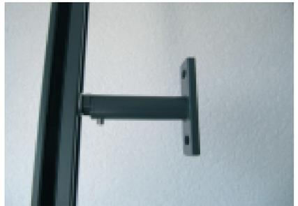
6. Die Teleskophalter in die Nut der Führungsschiene einschieben und mit der Klemmschraube an der ausgemessenen Position festschrauben. Die Imbusklemmschraube nach Einstellung der Distanz zum Fensterelement festziehen.
