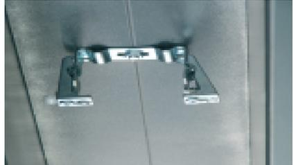
5. Den Raffstorebehang in die Oberleistenträger einhängen und zentriert ausrichten, danach Fixierschrauben festziehen.
